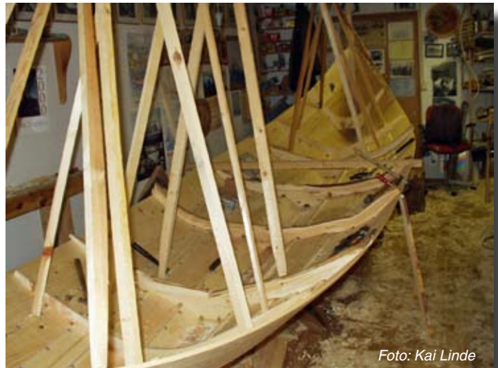
Den franske treroringen er liksom Fenrir en stor 3-roms båt på 9 ½ alen i røyset. Her felles det greinkroker til innved.
